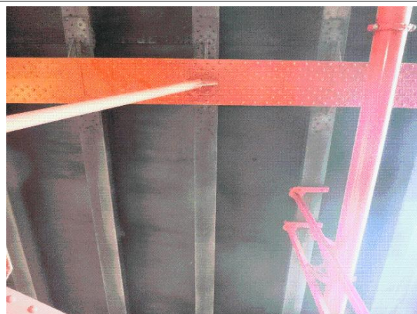
Prélèvement - P006 : Zone 6 W / Pylône NORD / Au droit de la 6e et 7e suspente / Travée NORD - Peinture - BE- (Présence d'amiante)
