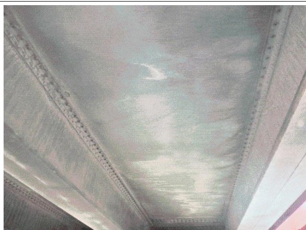
Prélèvement - P031 : Zone 4 E / Pylône NORD / Au droit de la 16e suspente / Travée principale - Peinture - BE- (Présence d'amiante)
