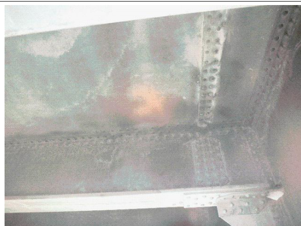
Prélèvement - P035 : Zone 5 E / Pylône NORD / Au droit de la 6e suspente / Travée principale - Peinture - BE- (Présence d'amiante)
