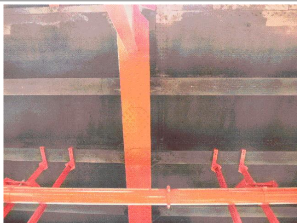
Prélèvement - P003 : Zone 6 E / Pylône NORD / Au droit de la 6e et 7e suspente / Travée NORD - Peinture - BE- (Présence d'amiante)
